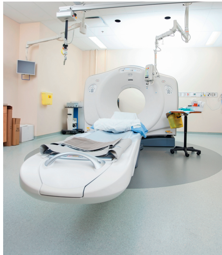
Salle de scanner
